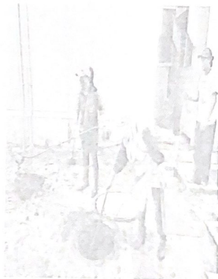
ตักกากไขมันออกจากบ่อและคัดแยกเศษขยะมูลฝอยบางส่วนออก พร้อมจุดหลุมฝัง ในแต่ละจุดของอาคารที่พัก
